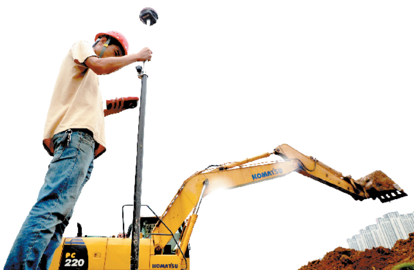
工作人员正在测量放线。
