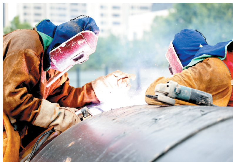
工人们正在进行暖气管道焊接。
