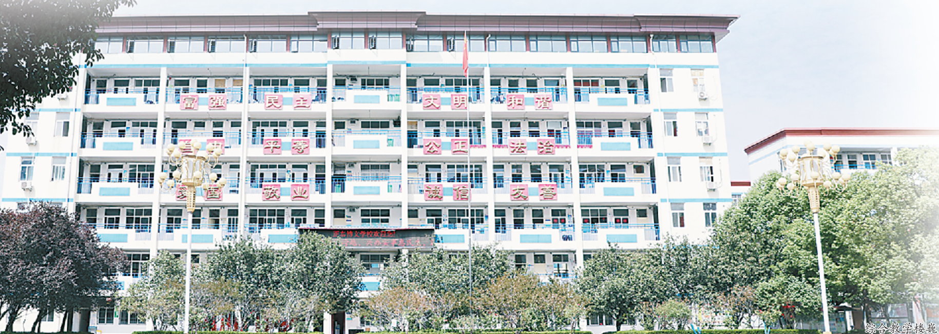
综合教学楼巍然耸立。
