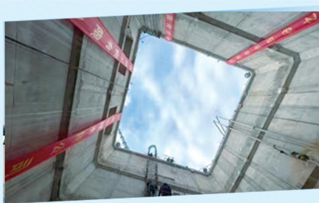
供暖管网过沙颍河工程作业井内景。
