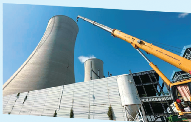
集中供暖首站施工现场。
