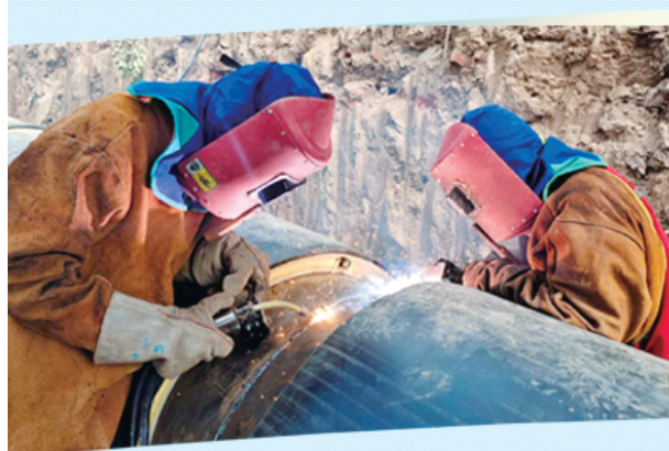
工人头戴面罩身穿防护服,冒着酷暑焊接供暖管道。
