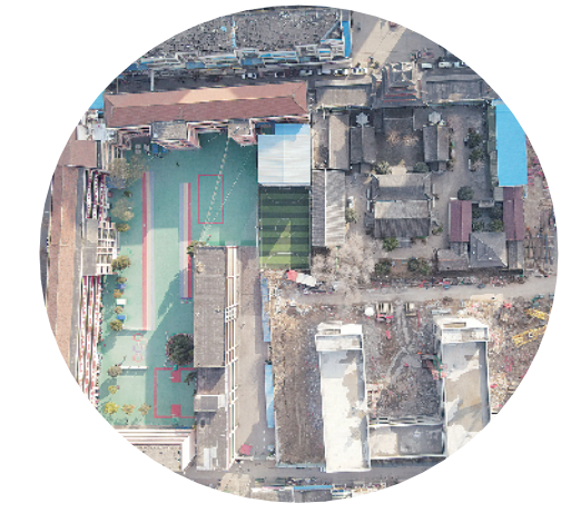
▲正在建设中的沈丘第二实验中学(东城实验学校),总投资约1.44亿元,项目规划总占地5.02万平方米,总建筑面积4.82万平方米,主要建设内容包括教学区、办公区、体育生活区、后勤及生活用房,设计60个教学班,可容纳3000名学生。
