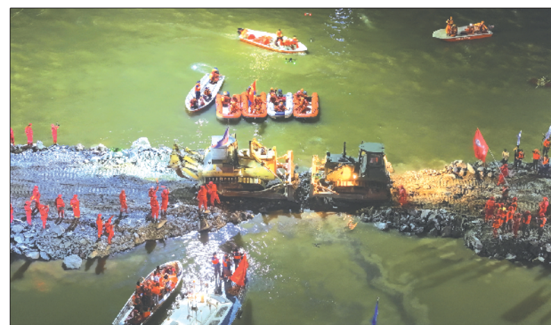
湖南华容县团洲垸洞庭湖大堤决口完成封堵
