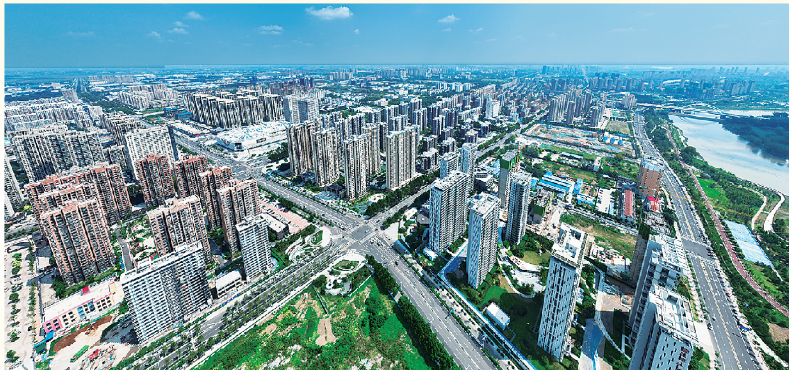
近年来,市城乡一体化示范区深入践行人民城市理念,立足城市空间结构特点和人口发展趋势,全面提升城市建设管理精细化水平,打造宜居、宜业、宜游的良好环境,让人民群众拥有更多的获得感、幸福感、安全感、归属感。图为高楼林立的示范区。
