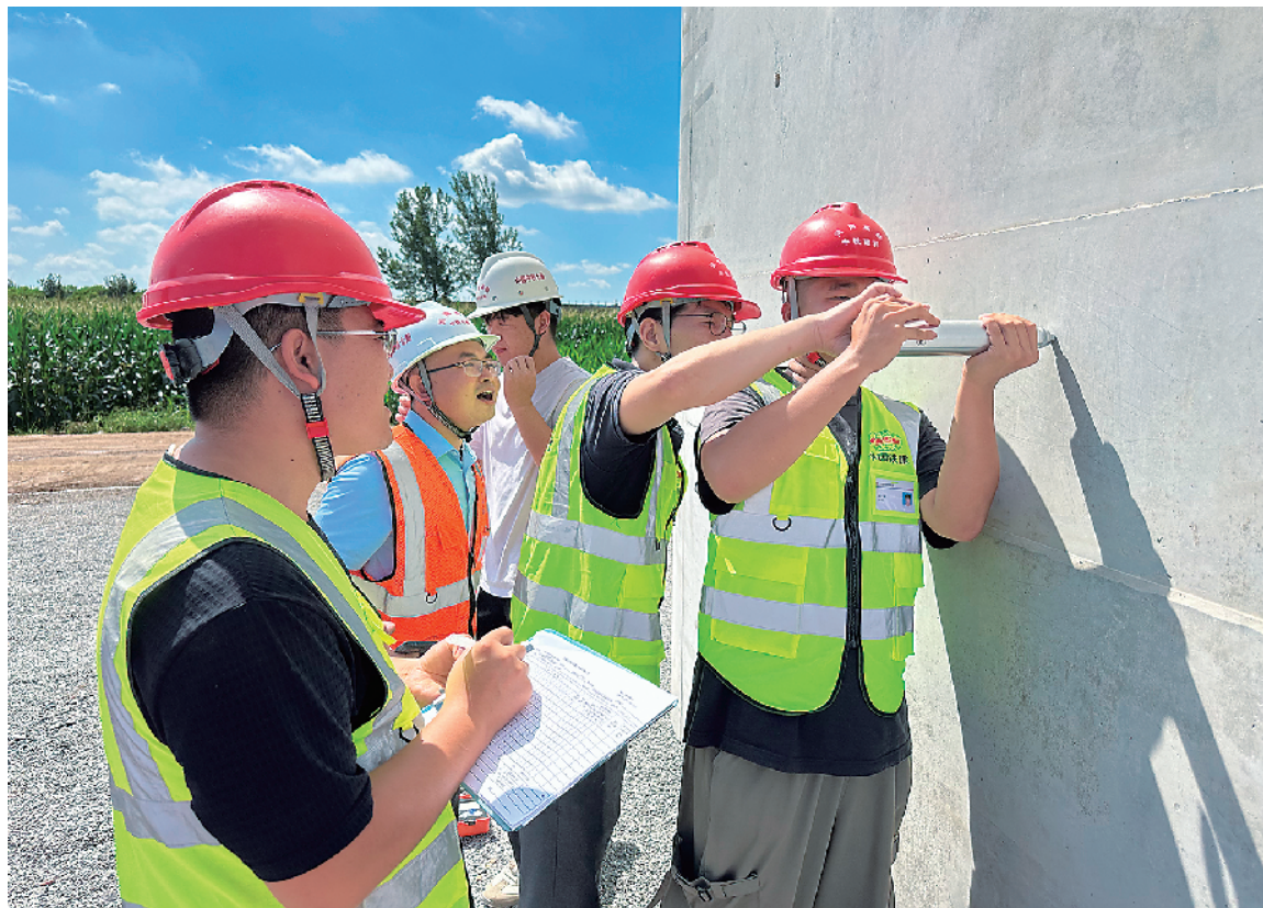
验收小组人员对商周特大桥91号墩身进行标准化施工验收评估。
