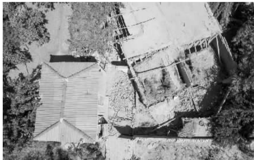
“安居富民房”经地震考验 在地震重灾区新疆皮山县皮西乡的一户庭院,农民自建的土坯房(右)被震塌,而旁边的“安居富民房”基本完好(7月4日摄)。记者在地震重灾区皮山县皮西乡采访时看到,不少土坯房在地震中发生了不同程度的损坏,但近年来修建的“安居富民房”却基本保持完好。2004年新疆实施抗震安居(安居富民)工程以来,共发生5级以上地震60多次,但经过多年抗震安居工程建设,新疆地震多发区及强震区已由被动救灾转变到震前主动防御。新华社发
